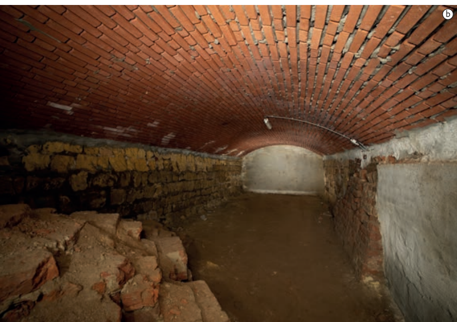
FIGUUR 8 De oude keldermuren van kelder 12 zijn grotendeels dicht gevoegd, waardoor vlemmuizen hoofdzakelijk in de het plafond overwinteren (a). De in 2009 nieuw gerealiseerde vlemmuiskelder 9. Tussen de gemetselde bakstenen zijn zeer veel wegkruipmogelijkheden gecreëerd door het openlaten van voegen (b) (foto's: Paul van Hoof).
