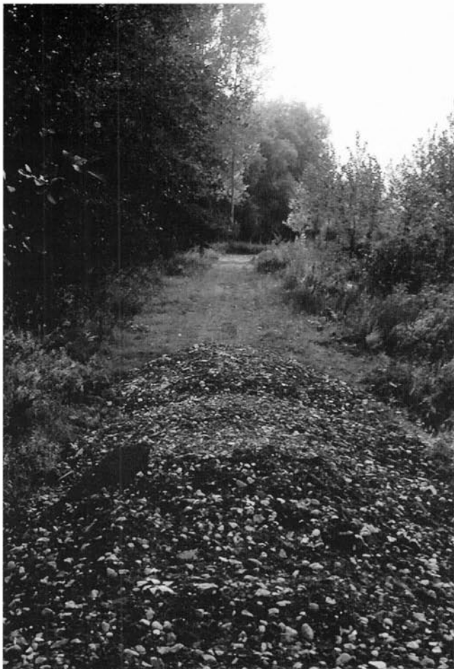
FIGUUR 3 Met gebroken asfalt en puin werden de paden opgehoogd.
