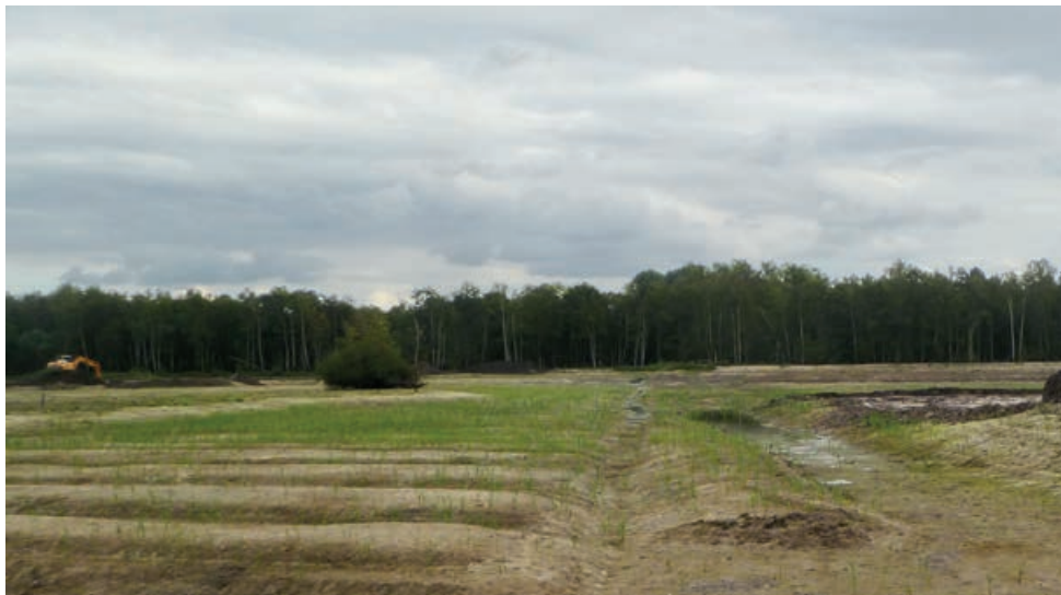
▲▲ FIGUUR 7 Infiltratie: 1 bovensloot; 3 bovenslootjes; 2 onderslootjes en 1 ondersloot (bron: JANSEN, 2015).
