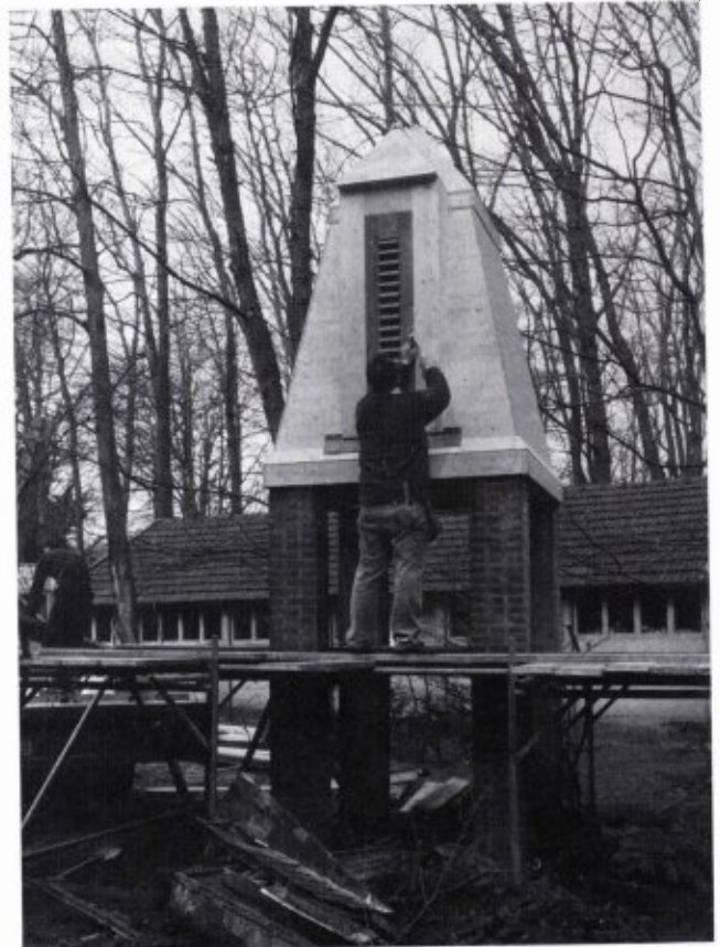
Figuur 3. Het aanbrengen van de "persiënne", 3 april 1987 (foto A.M. Voûte)
