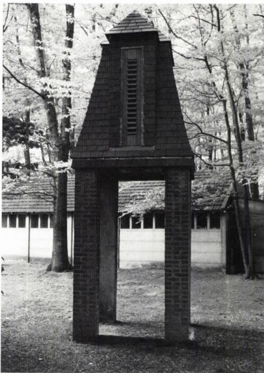
Figuur 4. De toren is geheel afgewerkt, ook de leien zijn aangebracht; 6 mei 1987 (foto A.M. Voûte)
