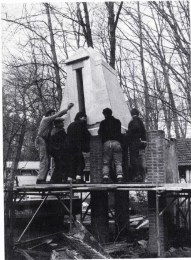
Figuur 2. Het plaatsen van de nieuwe toren, 3 april 1987. De leien zijn nog niet aangebracht (foto A.M. Voûte)
