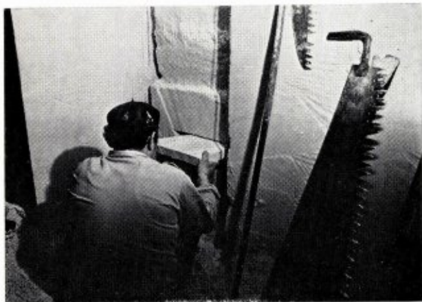
Foto 10. Als de plaat mergel losgewrikt is, kan hij uit de opening gehaald worden.
