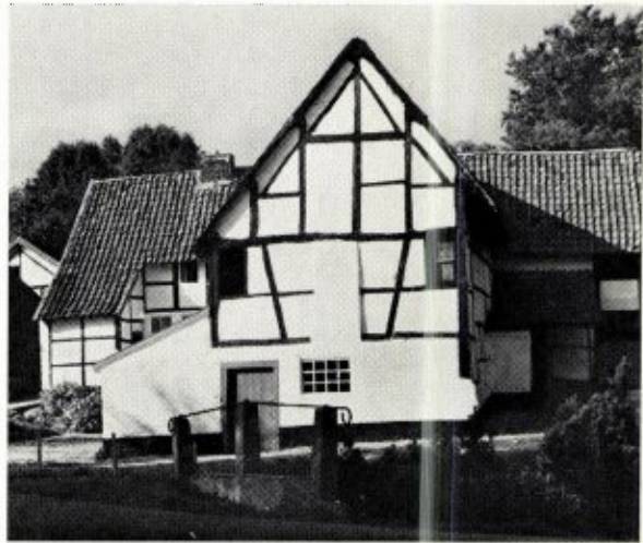
Foto 4: Vakbouwwooningen bij de Brigittabron te Wesch bij Noorbeek. Foto: J. Th. ter Horst.
